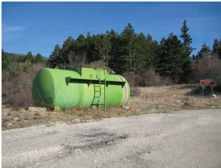
Photo 2 : Seconde réserve incendie à proximité de la carrière
